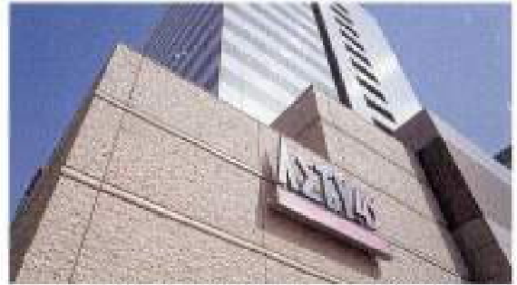
※デザイン型紙・特殊コンクリート散放し下地+エレガンススタイルTS(型紙未使用)
